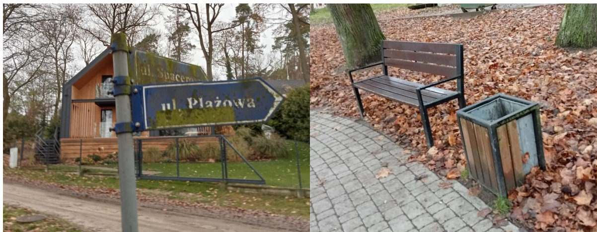
Ryc. 18. Zdegradowane elementy małej architektury zlokalizowane na obszarze rewitalizacji
