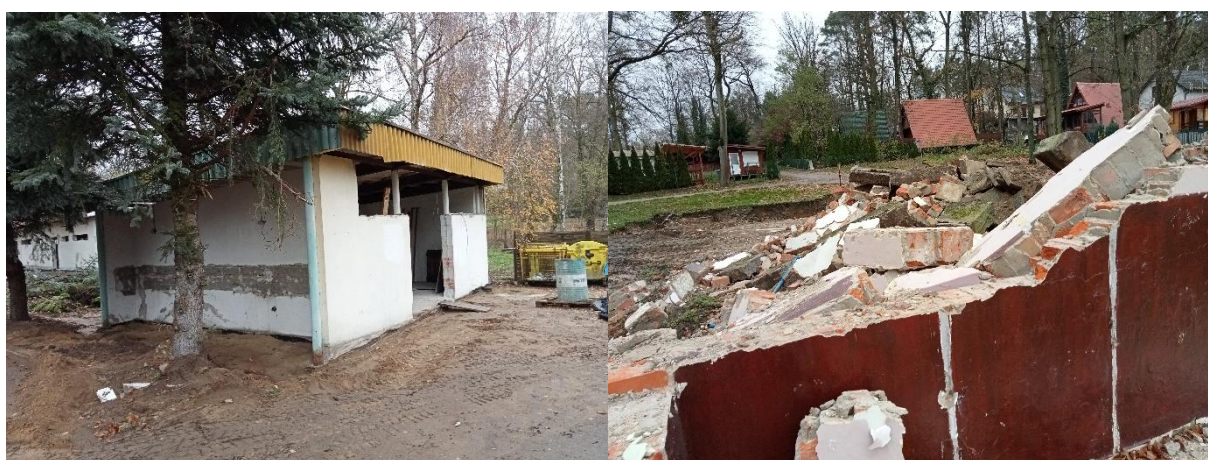
Ryc. 21. Dawne obiekty sanitarne przy jeziorze Lubasz
