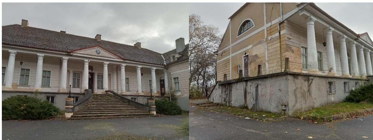
Ryc. 23. Niszczący pałac w Lubaszu
